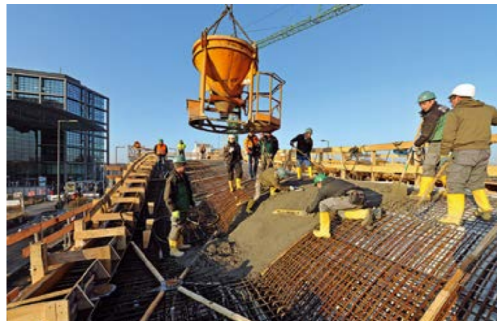
Der Leichtbeton wird manuell geglättet und verdichtet.
