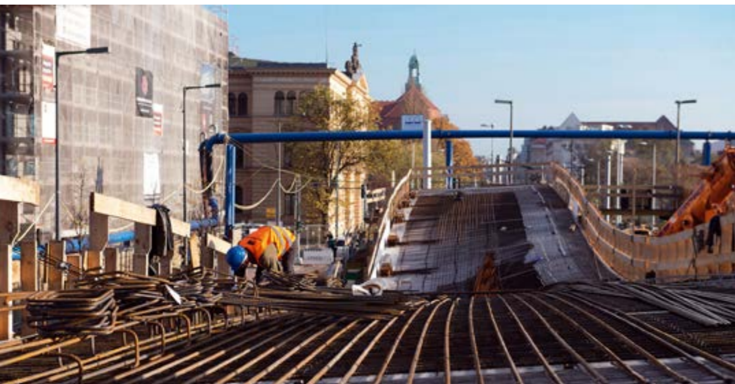
Keine Konstruktion für eine Achterbahn, vielmehr die Schalung für ein komplexes Dachtragwerk, das hinterher durch Leichtigkeit überzeugt.
